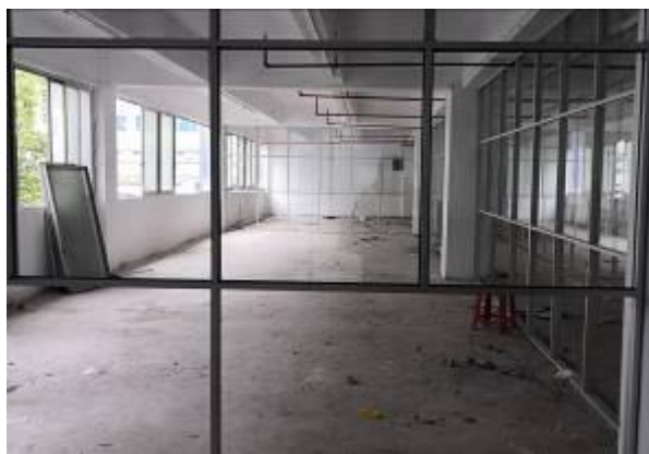
项目 2 楼车间现状图
