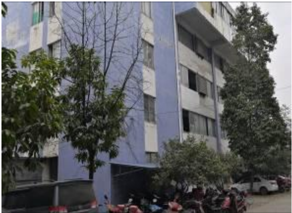
项目西面的工业厂房
